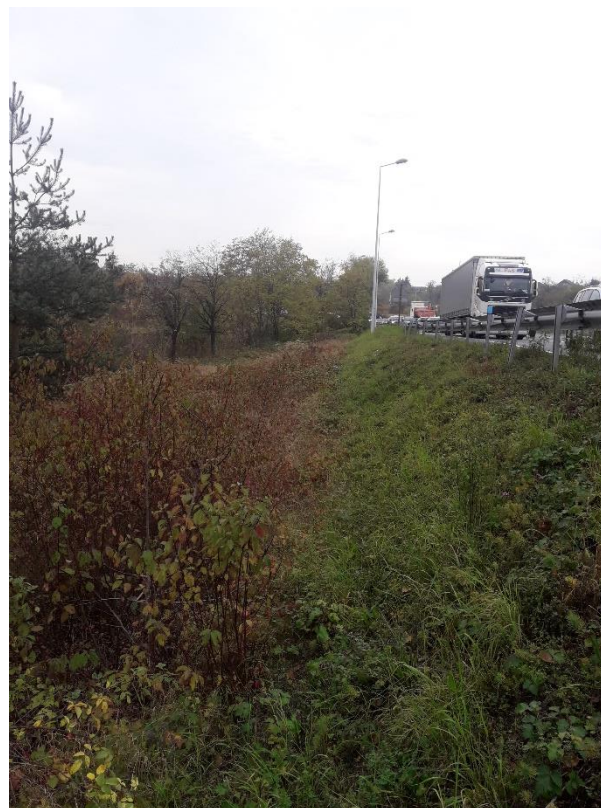
Vue du remblai
