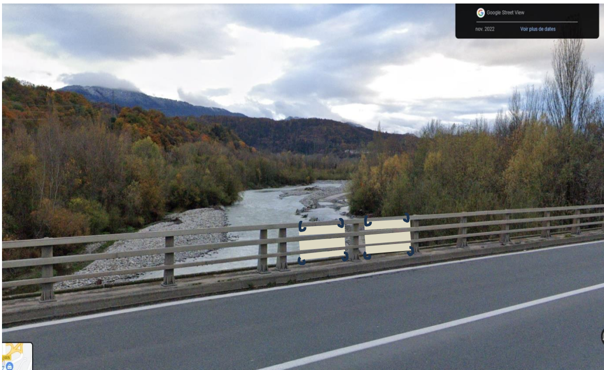
Montage (vue vers l'amont)
