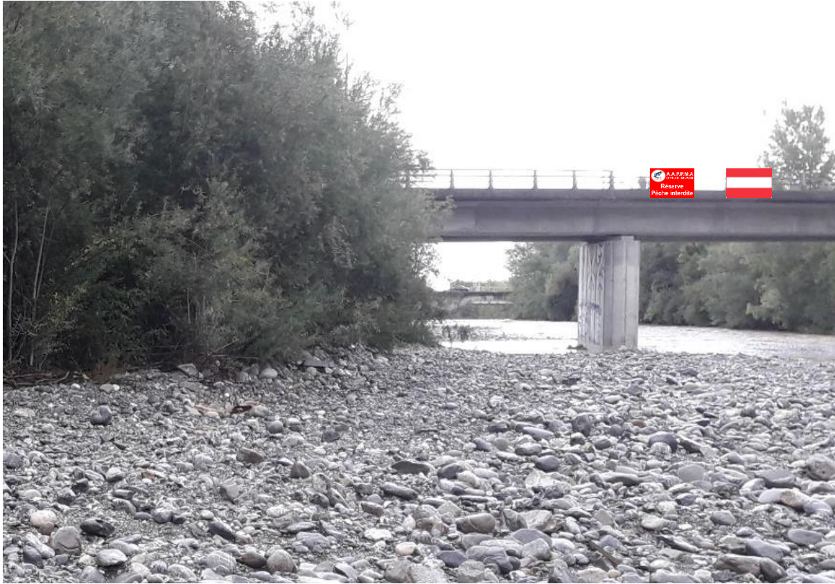
Montage (vue vers l'aval)
