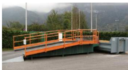
La zone de déchargement des gravats
