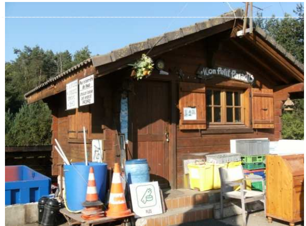
Service Eau Déchets Energies - CG74 - janvier 2012
