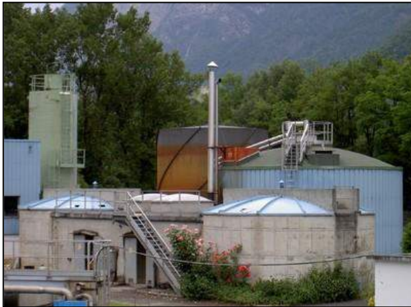
Méthaniseur de station d'épuration
