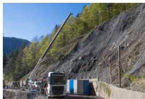
Le chantier en avril 2017 à son démarrage.
