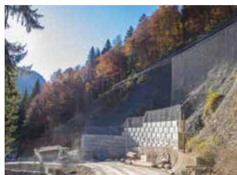
Le chantier en octobre 2017 après réalisation des murs de protection.
