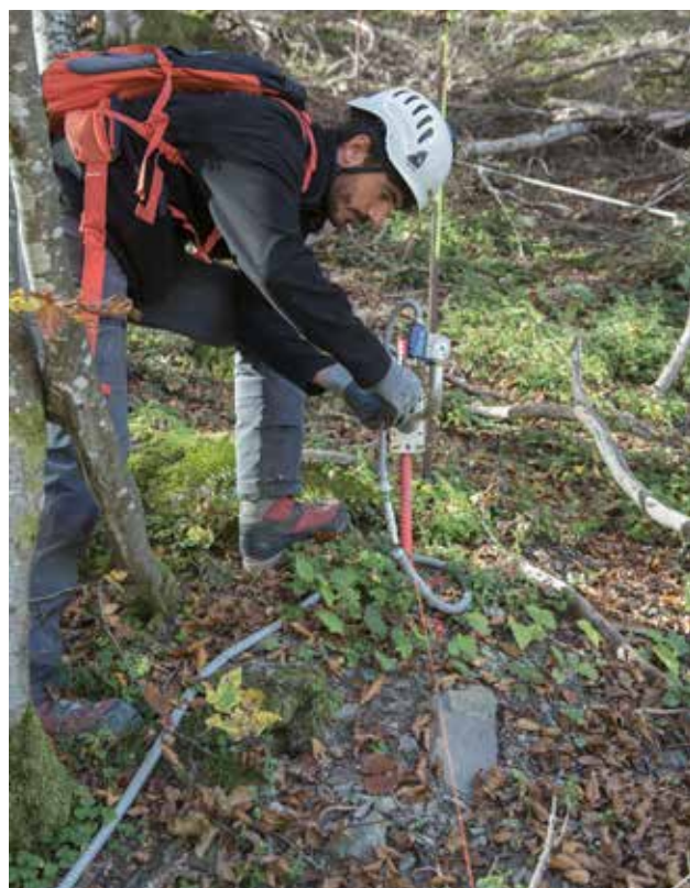
Installation du système de détection automatique d'événements.
