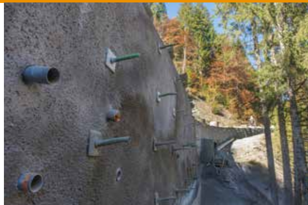
La paroi clouée aval est construite.
