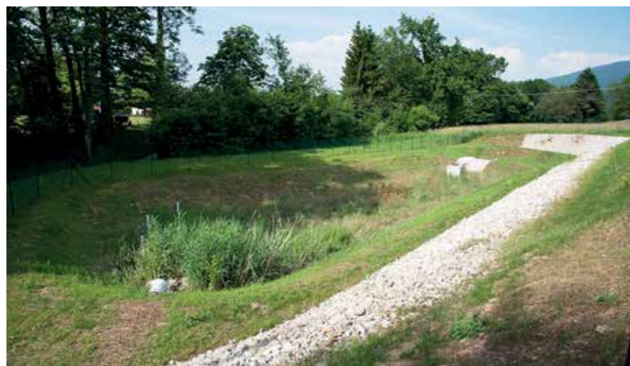
Exemple d'un bassin de traitement des eaux de chaussées.
