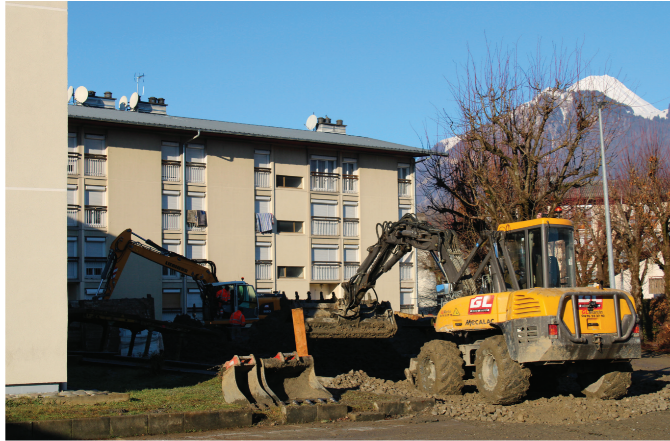
Les pelleteuses creusent dans le quartier du Crozet.
